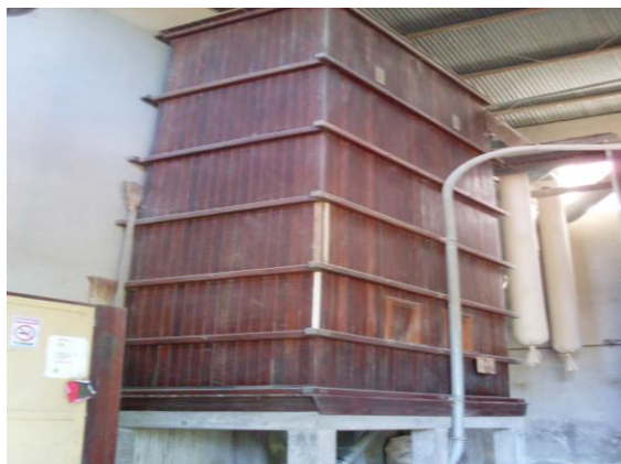
Figura 01- Caixa Depósito utilizada para armazenar os grãos dentro do moinho.
